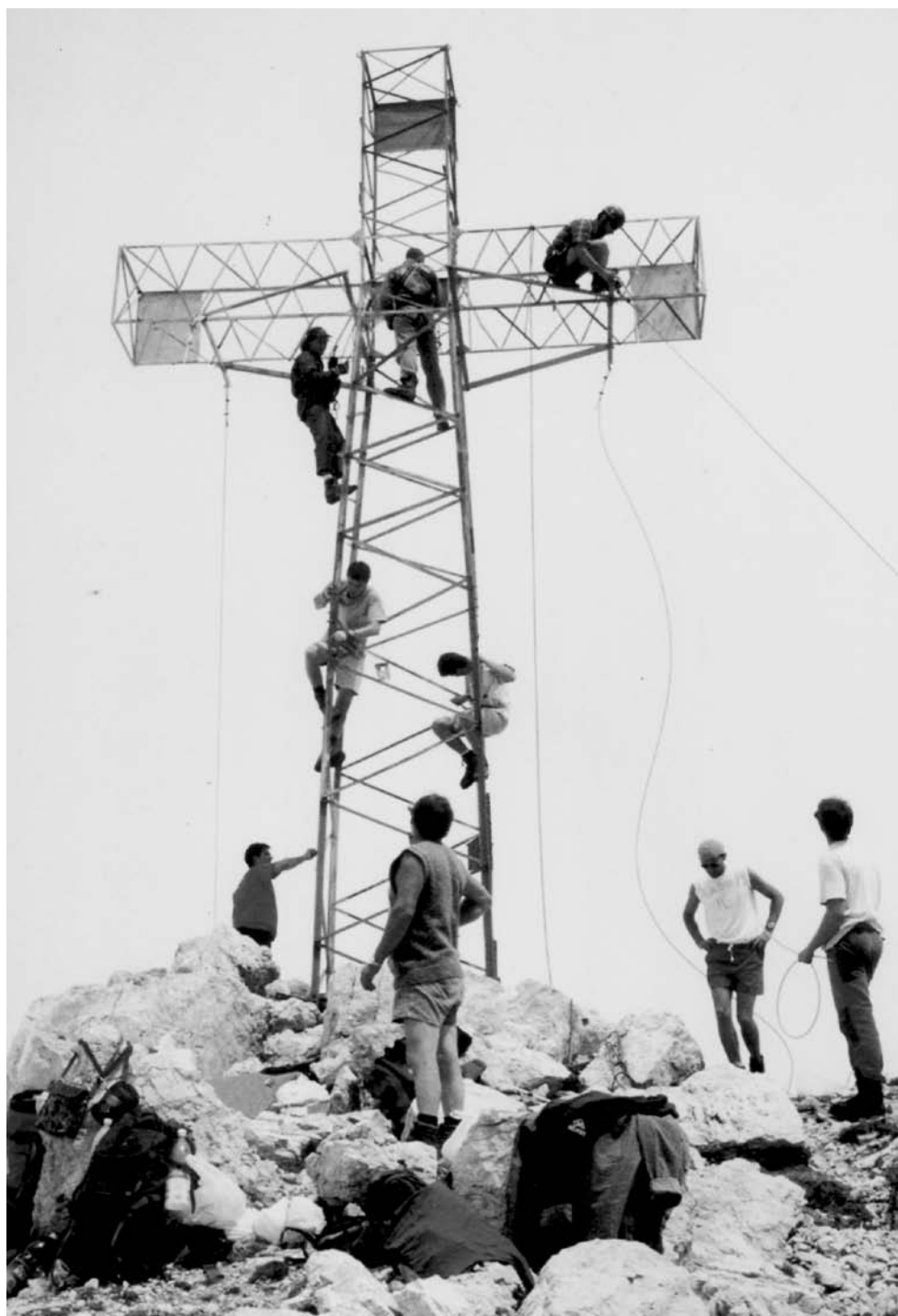
Manutenzione ordinaria alla Croce
